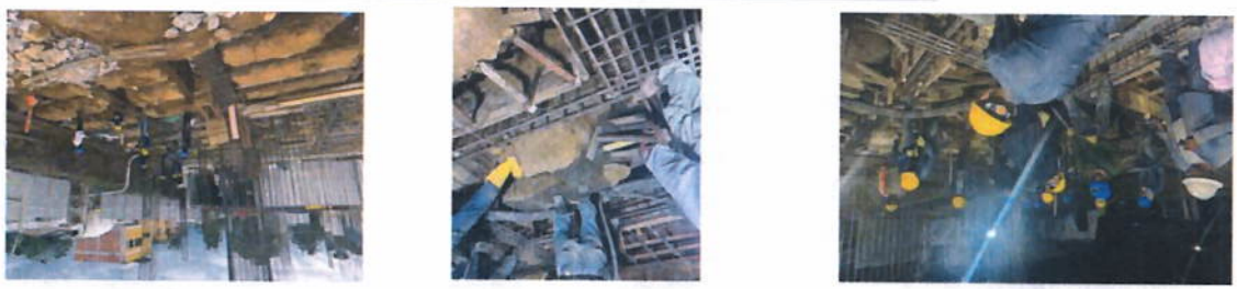
ARMADO DE ACERO DE REFUERZO PARA VIGAS DE CIMENTACION
