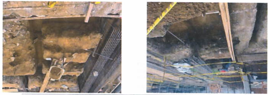
VACIADO DE CONCRETO VIGAS DE CIMENTACION ENTRE Ejes 6-9 Y Ejes AP
