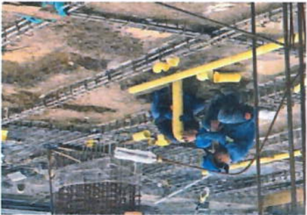
ARMADO DE REDES SANITARIAS PARA BATERIA DE BAÑOS ENTRE Ejes 7 Y 8 Y Ejes DE
