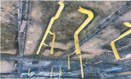
ARMADO DE REDES SANITARIAS PARA BATERIA DE BAÑOS ENTRE Ejes 7 Y 8 Y Ejes DE
