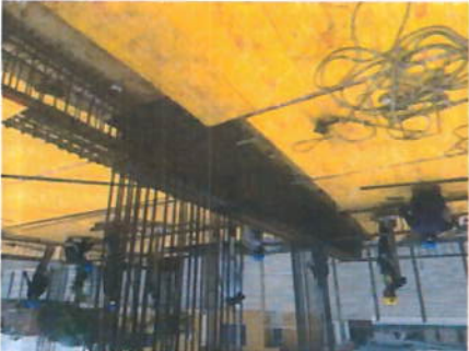
ARMADO DE ACERO DE REFUERZO PARA VIGAS DE ENTRE PISO ENTRE Ejes AF Y Ejes 1 Y 4
