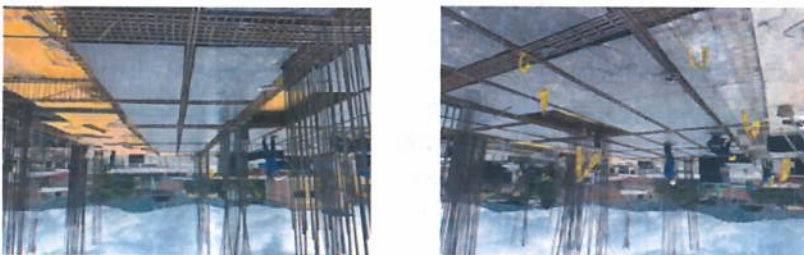
ARMADO Y AMARRE DE ACERO
