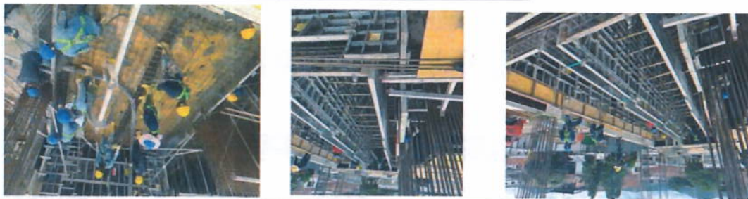
ARMADO DE MUROS Y VACIADO DE CONCRETO TANQUE DE SERVICIOS
